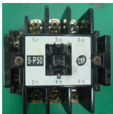
圖 6、電磁接觸器
