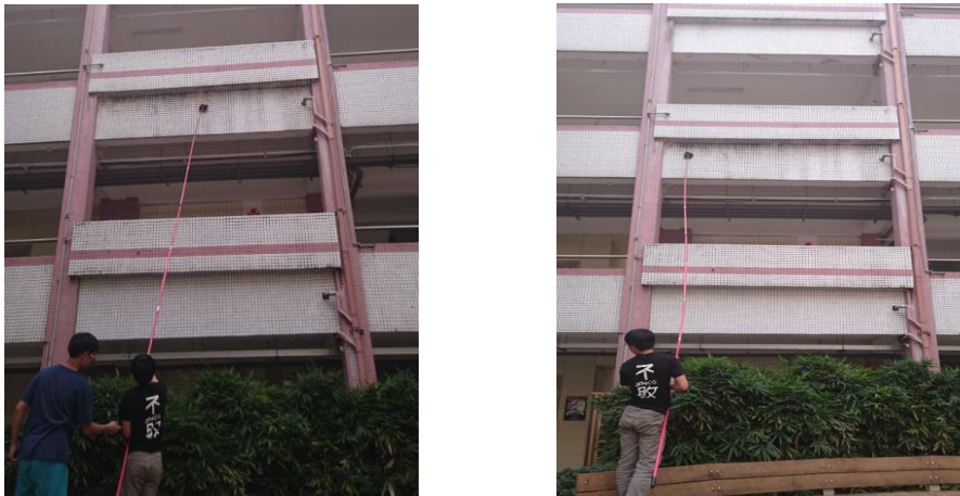
(圖十二) 以長柄抹布刷刷除三樓外牆污物
