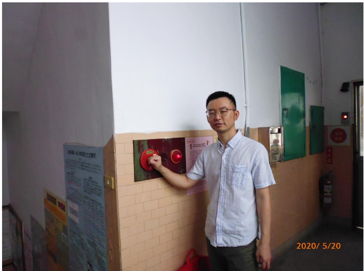
說明 12：109 年 5 月 20 日火災滅火演練(按壓火災綜合盤告知民生樓師生發生
