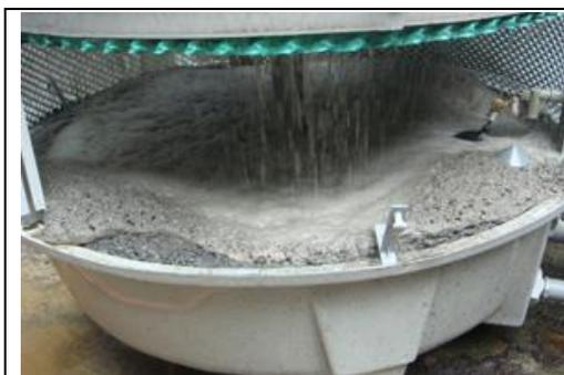
圖 3.以化學藥劑清洗冷卻水塔
