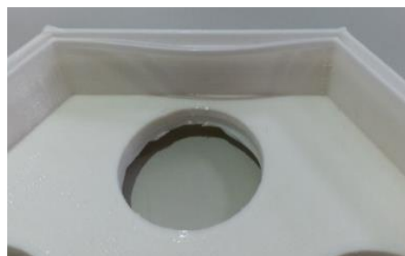
(圖七) 母槽崩裂現象
