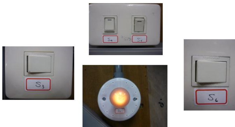
圖 7 四處控制一燈(S3、S4、S5、S6 可四處控制一燈 R2)
